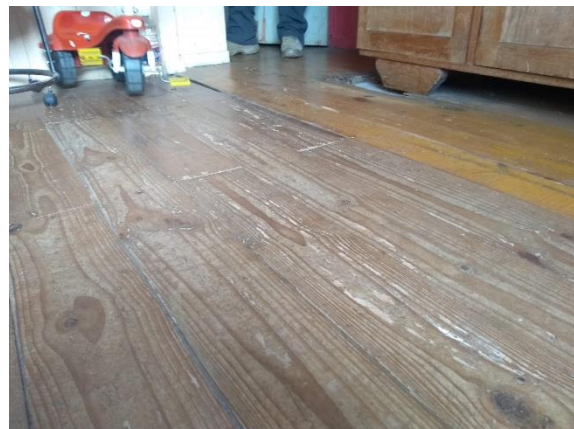
Figura 49: Piso desnivelado.
