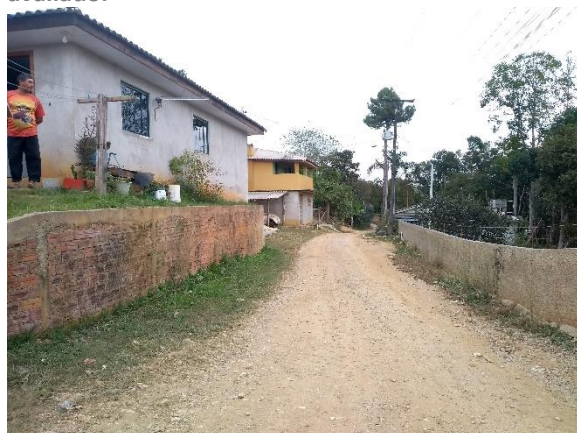
Figura 81: Edificações de alvenaria no setor de risco avaliado.
