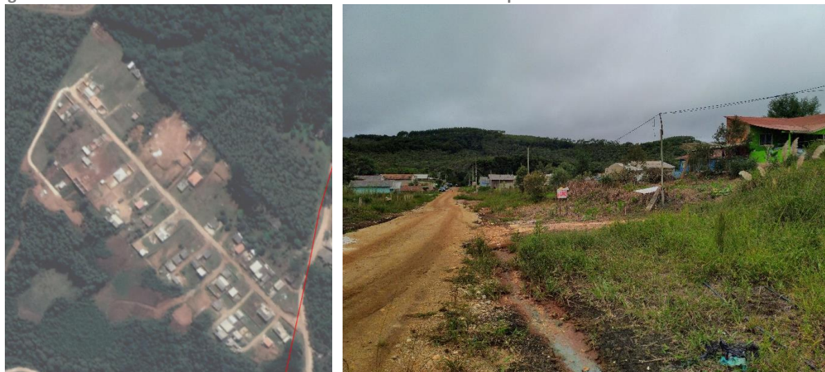
Figura 150: Ausência de infraestrutura em loteamento clandestino próximo à zona industrial.
