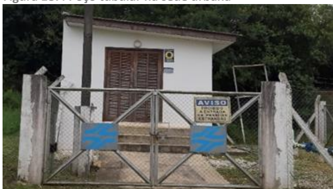
Figura 187: Poço tubular na sede urbana
