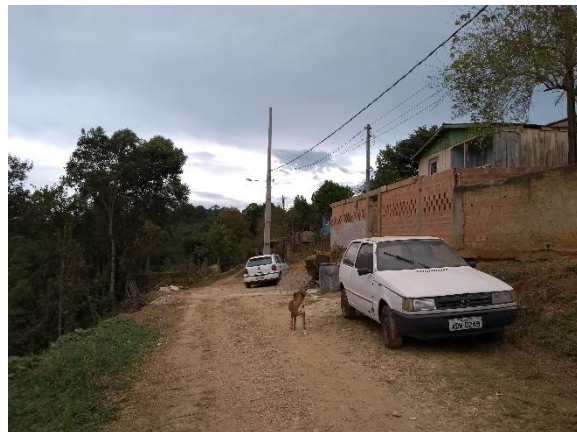
Figura 54: Residência com padrão construtivo misto e a rua sem alfato.
