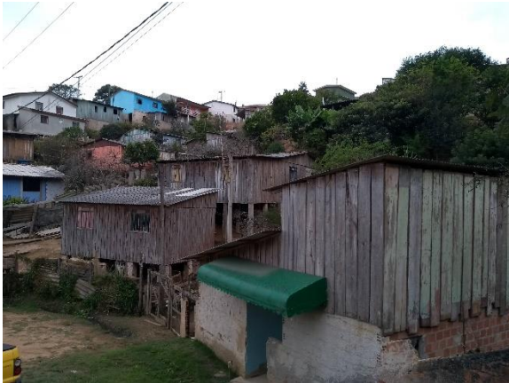
Figura 67: Edificações de madeira no setor de risco avaliado.
