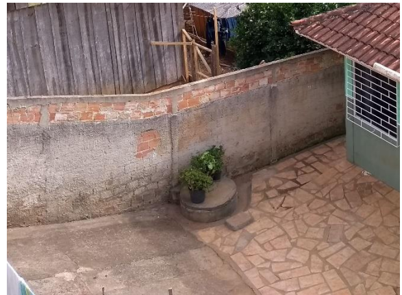
Figura 62: Fossa no imóvel existente na porção central do setor de risco.
