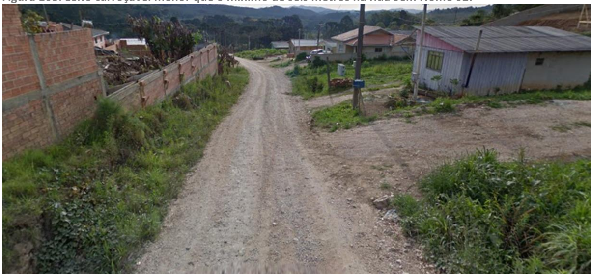
Figura 168: Leito carroçável menor que o mínimo de seis metros na Rua Sem Nome 027
