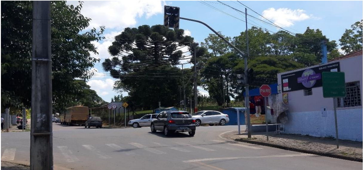
Figura 169: Cruzamento da BR-476 com a Rua Quintino Bocaiúva, onde o semáforo está inativo.
