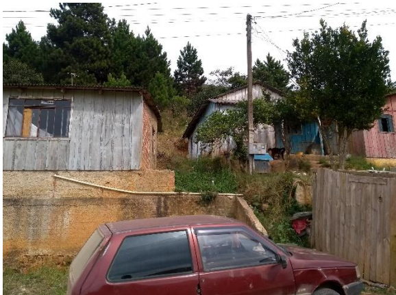
Figura 31: Edificações de madeira no setor de risco avaliado.
