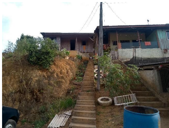
Figura 44: Residência com padrão construtivo misto.
