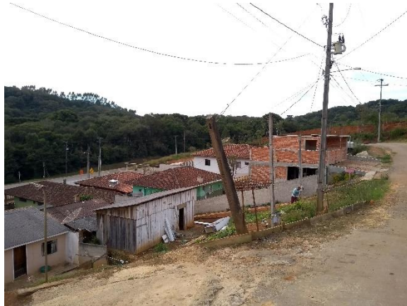
Figura 59: Edificações de madeira no setor de risco avaliado.
