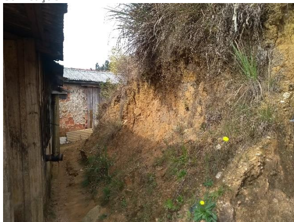
Figura 36: Corte de talude sub-vertical junto a edificação.
