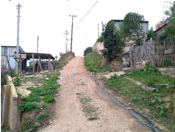
Figura 69: Estrada de acesso no setor de risco com esgoto escoando superficialmente.
