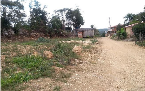
Figura 83: Estrada de acesso no setor de risco.
