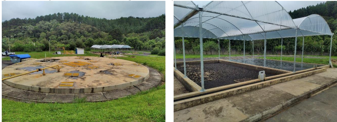
Figura 188: Estação de Tratamento de Esgoto – ETE Tapera na sede urbana
