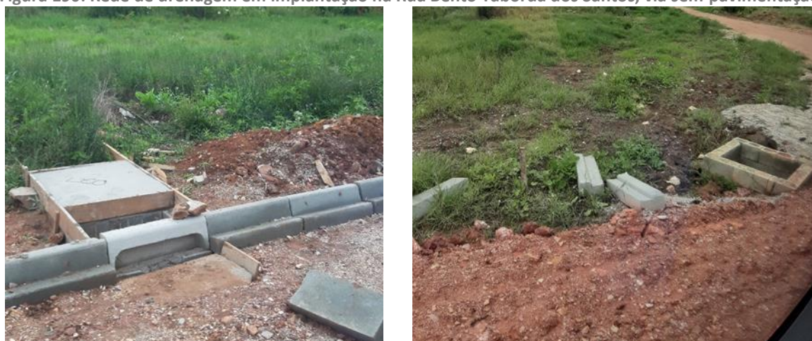
Figura 190: Rede de drenagem em implantação na Rua Bento Taborda dos Santos, via sem pavimentação
