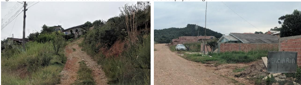
Figura 141: Ausência de infraestrutura urbana em áreas de ocupação irregular
