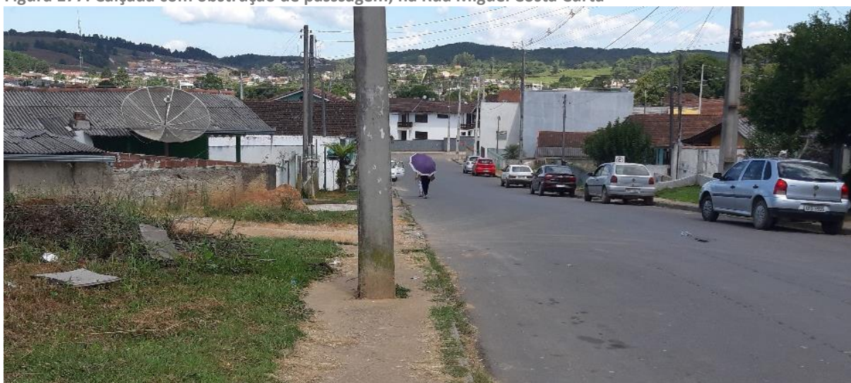
Figura 177: Calçada com obstrução de passagem, na Rua Miguel Costa Curta
