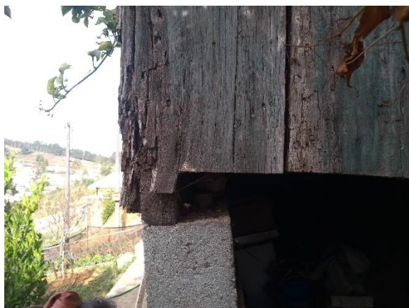
Figura 50: Muro inclinado.
