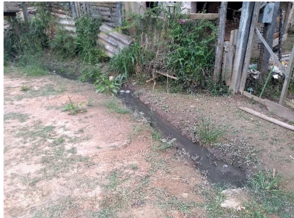
Figura 70: Efluente doméstico sobre a frente da residência localizada no setor de risco.
