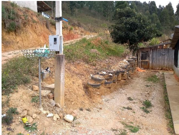
Figura 39: Corte de talude contido por pneus.
