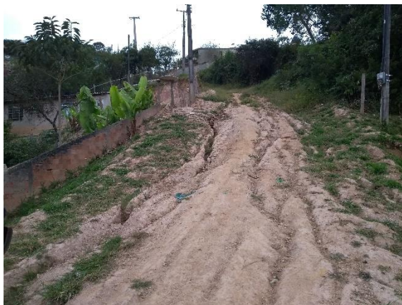
Figura 79: Ravinamento do solo por enxurradas.
