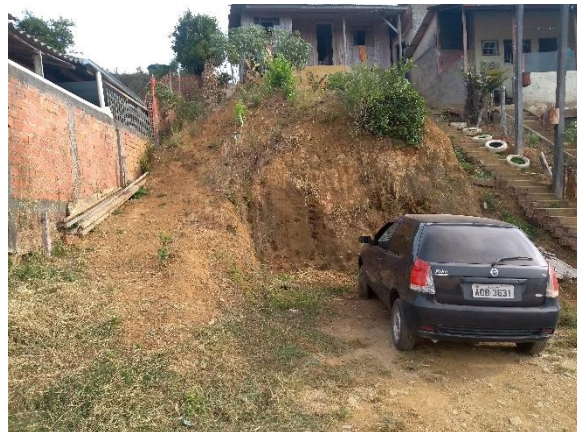
Figura 47: Corte de talude.
