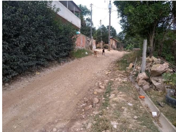
Figura 84: Rua sem asfalto no setor de risco avaliado.
