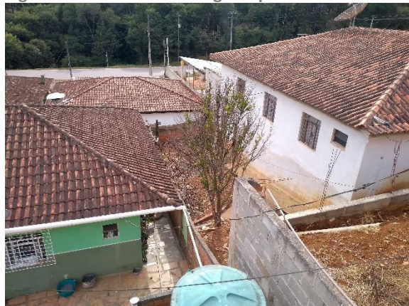
Figura 65: Residências atingidas por enxurradas.
