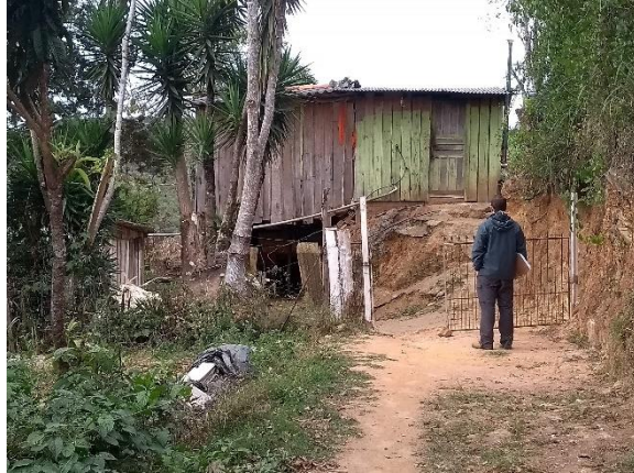
Figura 86: Ocupação residenciais junto ao corte sub-vertical de talude.
