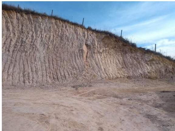
Figura 56: Corte sub-vertical do morro situado no extremo sudeste do setor aditivo.
