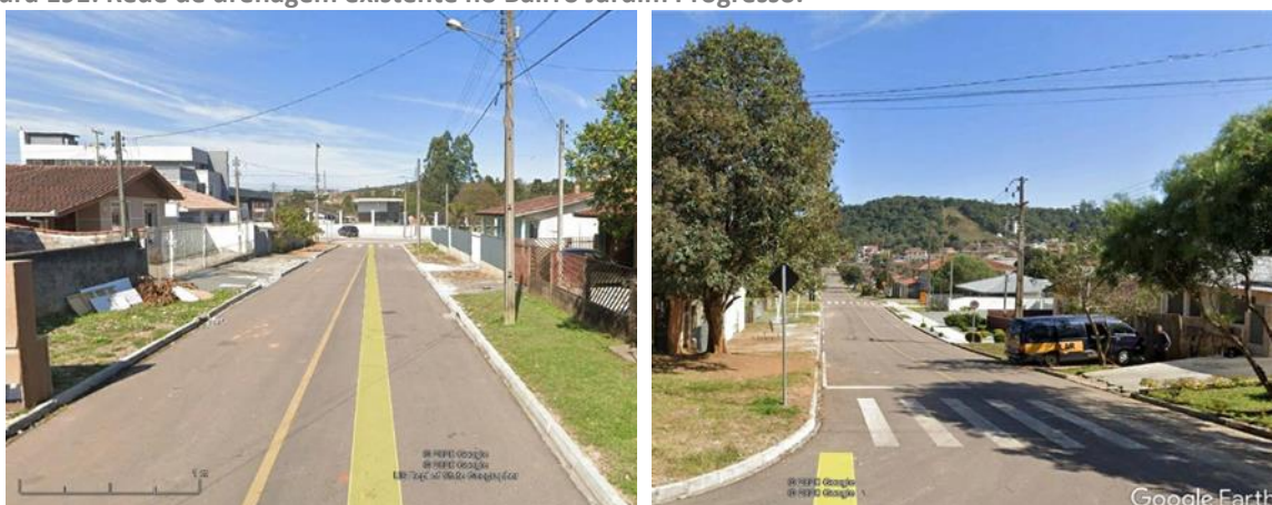
Figura 191: Rede de drenagem existente no Bairro Jardim Progresso.
