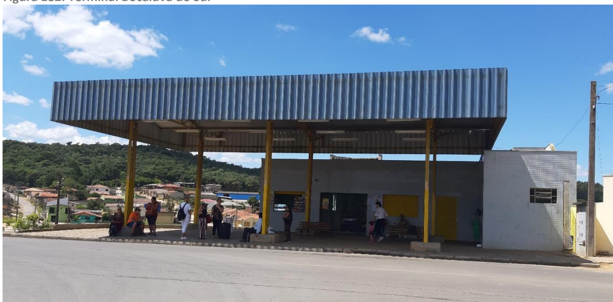
Figura 182: Terminal Bocaiúva do Sul
