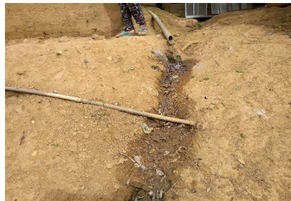
Figura 17: Efluente doméstico sobre a superfície do terreno.
