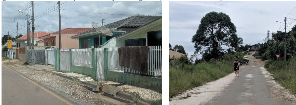
Figura 82: Inexistência de passeios e calçadas irregulares, causando riscos aos pedestres.
