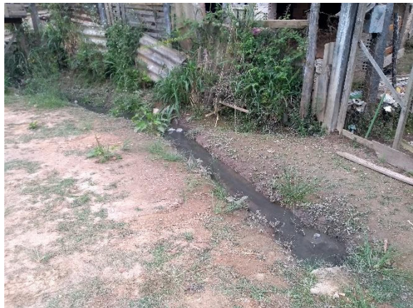
Figura 53: Efluente doméstico sobre a frente da residência localizada no setor de risco.
