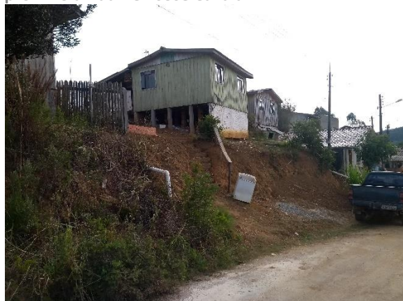
Figura 29: Corte de talude em ângulo sub-vertical próximo à Rua Ver. José Cavallari.
