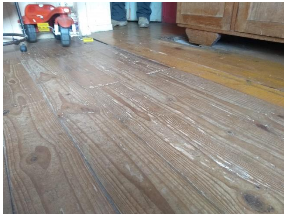
Figura 32: Piso desnivelado.
