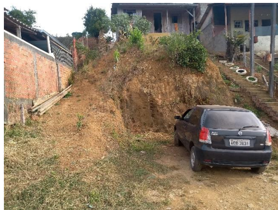
Figura 29: Corte de talude em ângulo sub-vertical próximo à Rua Ver. José Cavallari.
