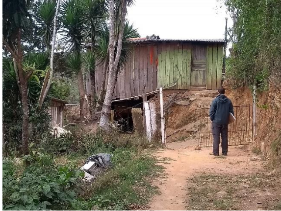
Figura 69: Ocupação residenciais junto ao corte sub-vertical de talude.
