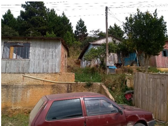
Figura 14: Edificações de madeira no setor de risco avaliado.
