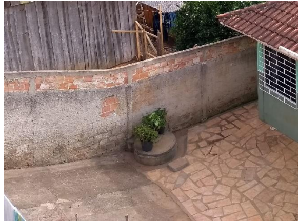
Figura 45: Fossa no imóvel existente na porção central do setor de risco.
