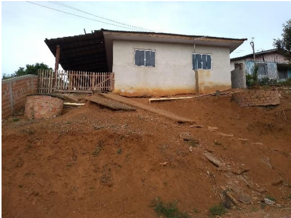
Figura 44: Fossa existente em frente à residência.
