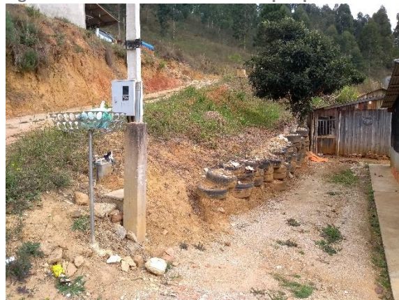
Figura 22: Corte de talude contido por pneus.
