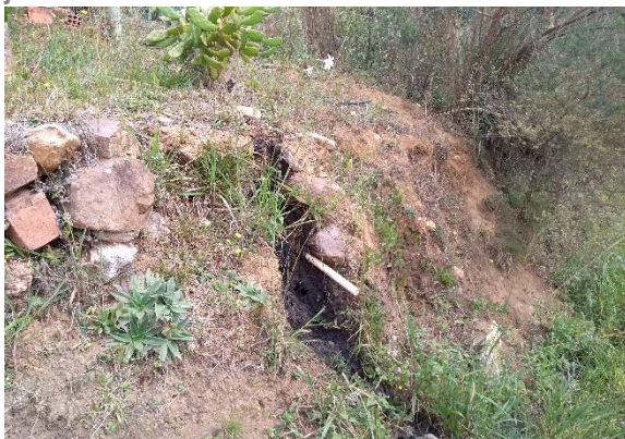
Figura 16: Tubo de pvc direcionando o esgoto para jusante.
