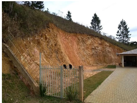
Figura 20: Corte de talude para ocupação residencial.
