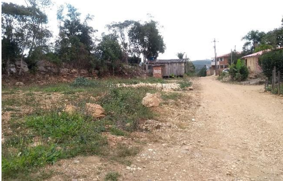
Figura 66: Estrada de acesso no setor de risco.
