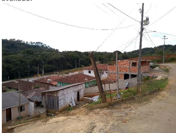
Figura 42: Edificações de madeira no setor de risco avaliado.
