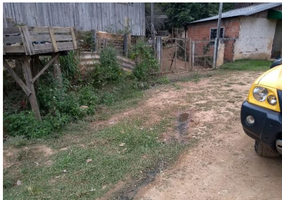
Figura 55: Efluente doméstico sobre a superfície do terreno.
