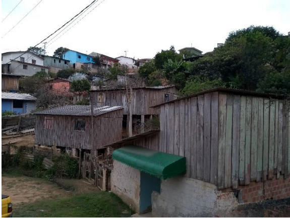
Figura 50: Edificações de madeira no setor de risco avaliado.
