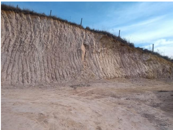
Figura 39: Corte sub-vertical do morro situado no extremo sudeste do setor aditivo.
