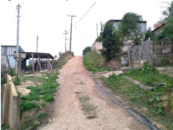
Figura 52: Estrada de acesso no setor de risco com esgoto escoando superficialmente.
