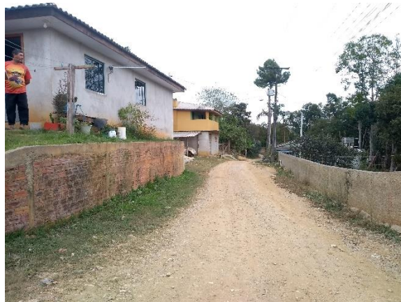
Figura 64: Edificações de alvenaria no setor de risco avaliado.
