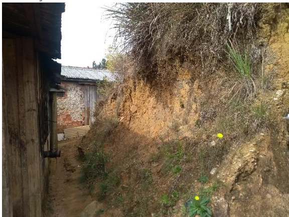
Figura 19: Corte de talude sub-vertical junto a edificação.
